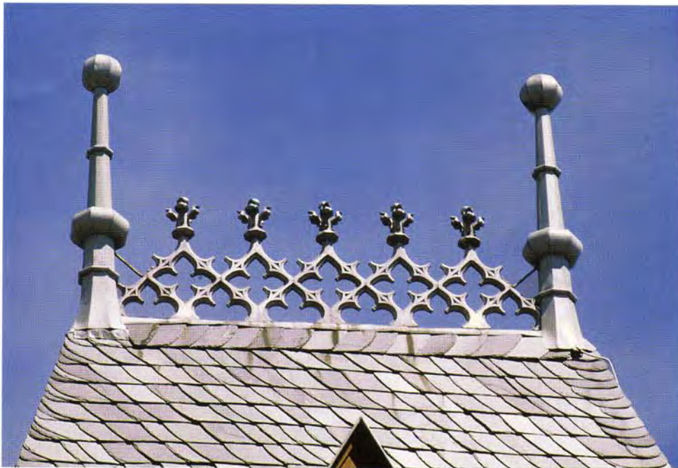
Metallgitter mit Eckpfosten als Firstreiter auf einem Schiefertürmchen mit Englischer Deckung, Lüttich, Belgien. Das Gitter und die Eckpfosten bestehen aus einem mit Blei ummantelten Eisenkern.
