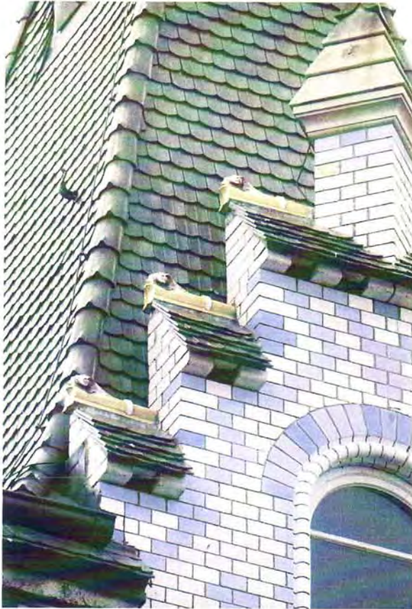
Die „vollkeramische“ Außenhülle der Ohm'schen Villa in Meißen: Meisterhafte Gestaltung von Dach, Treppengiebelabdeckung und Fassade mit keramischen Bauteilen.
