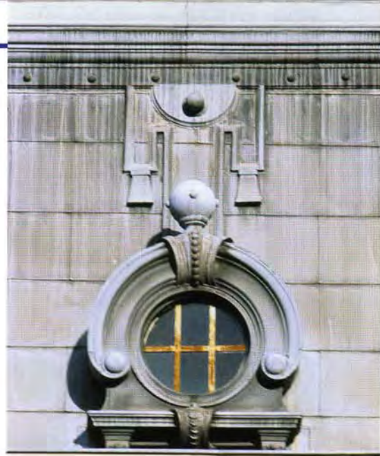
Die Dachbauteile und Schmuckelemente bestehen aus Blei und sind mit wenigen Instandsetzungsspuren mehr als einhundert Jahre alt (Lüttich, Belgien).
