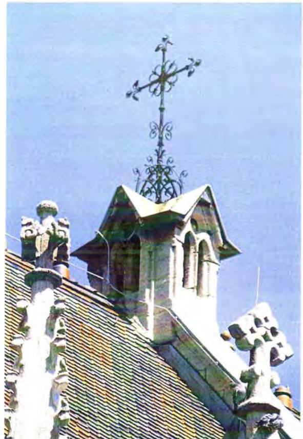
Gesamtkunstwerk Kirchendach, evangelische Stadtkirche in Meiningen: Werkstein-Elemente, changierende Dachziegeldeckung, keramischer und schmiedeeiserner Schmuck zeigen eine überzeugende Harmonie.
