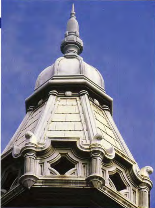
Eine Turmbekrönung aus Blei auf Eichenholz in Budapest, Ungarn. Dieser aus dem Ende des 19. Jahrhundert stammende Turmaufsatz stellt ein Musterbeispiel für die Langlebigkeit von meisterhaft gefertigten Metall-dächern dar.
