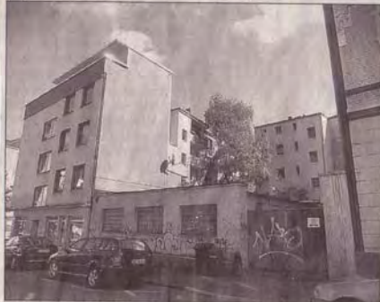
An der Franzstraße findet sich diese Baulücke. An manche hat man sich so gewöhnt, dass sie einem kaum noch auffallen.
